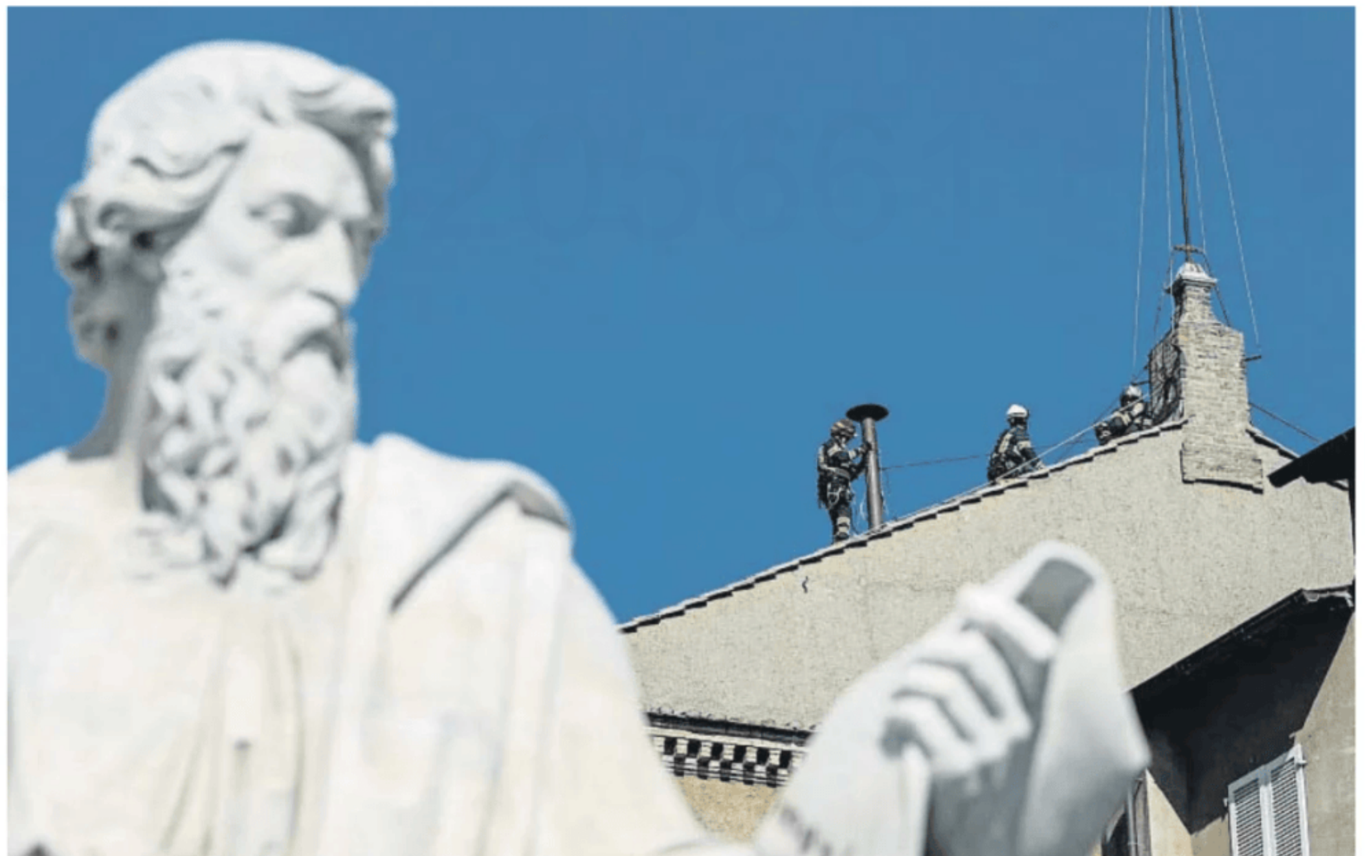
Un grupo de operarios instala la chimenea de la que saldrá la fumata del cónclave
